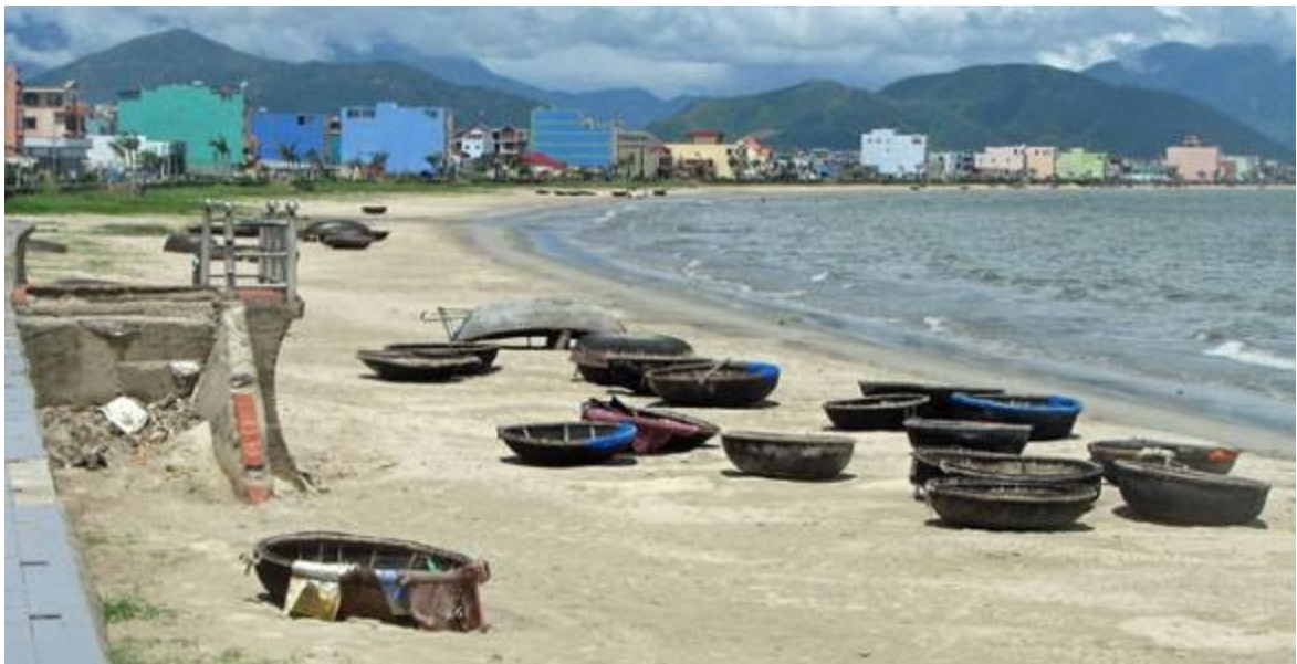
Ảnh 9: Các toà nhà sát bờ biển với rất ít phương tiện bảo vệ
