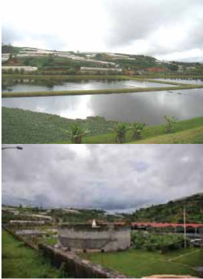
Nhà máy xử lý nước thải thành phố Đà Lạt
